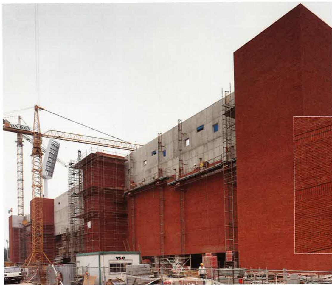
Bij het Koning Boudewijnstadion te Brussel is een muur van 150 meter lang en 23 meter hoog verlijmd met bakstenen naar ontwerp van de architect bOb Van Reeth.
